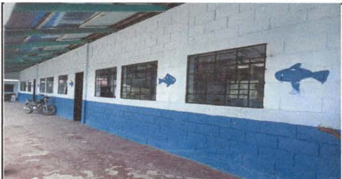
Foto 6: Fabricación e instalación de balcones de hierro en ventana. Módulo I
