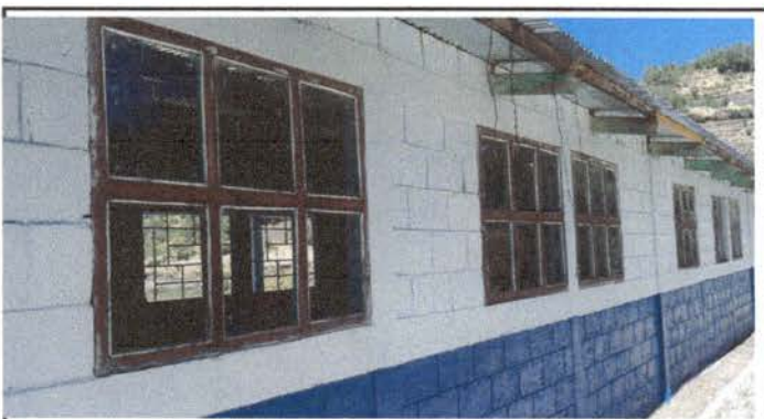
Foto 4: Sustitución de ventanas de madera por ventanas de metal mas vidrio en módulo I
